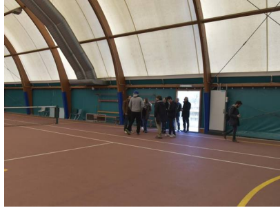
Uno degli impianti del Villaggio dello Sport
